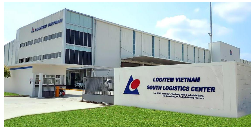
サウスロジスティクスセンター（ベトナム）
