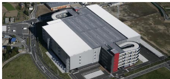
野田営業所が2階部分を使用するロジスティクスパーク野田船形の全景
