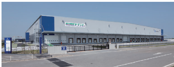
5月から稼働した「博多アイランドシティ物流センター」
