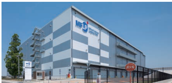
平成 29 年 10 月に開設した「稲沢センター」が入居している施設
