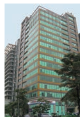
ロジテムベトナム ホールディングス (ハノイ本社事務所)
