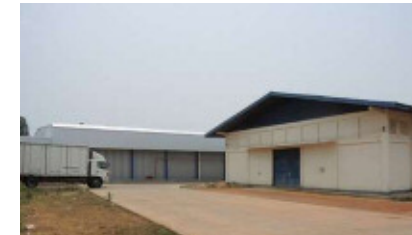
ラオス新倉庫
